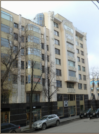
Рис. 10. Результат коррекции перспективы на автоматических настройках. Здание теперь стоит более ровно, но дефект преобразования виден в правом нижнем углу
