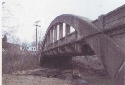
В штате Огайо над рекой Шейд есть мост Радуги. За счет этой арки он может одним пролетом перекрыть весьма приличное расстояние.
